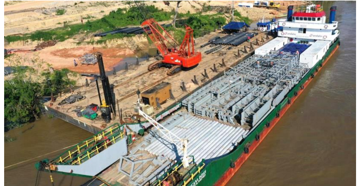
Pengiriman material untuk konstruksi konveyor
