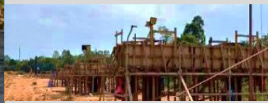
Pembangunan crushing plant
